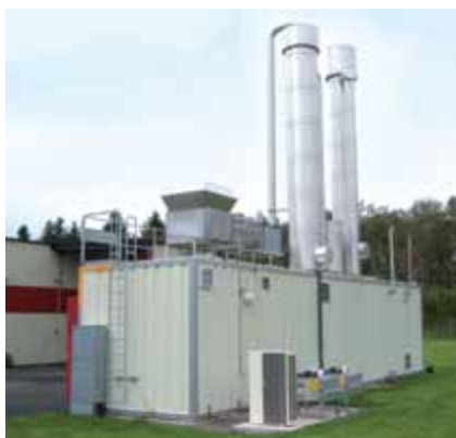
Abb. 8: Druckwasserwäsche [13]
