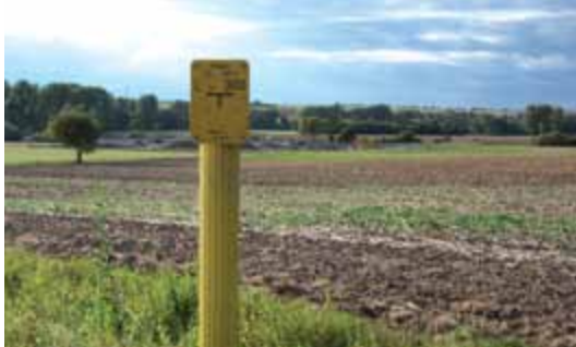
Abb. 16: Erdgasnetz, Hinweisschild auf eine unterirdische Leitung [13]
