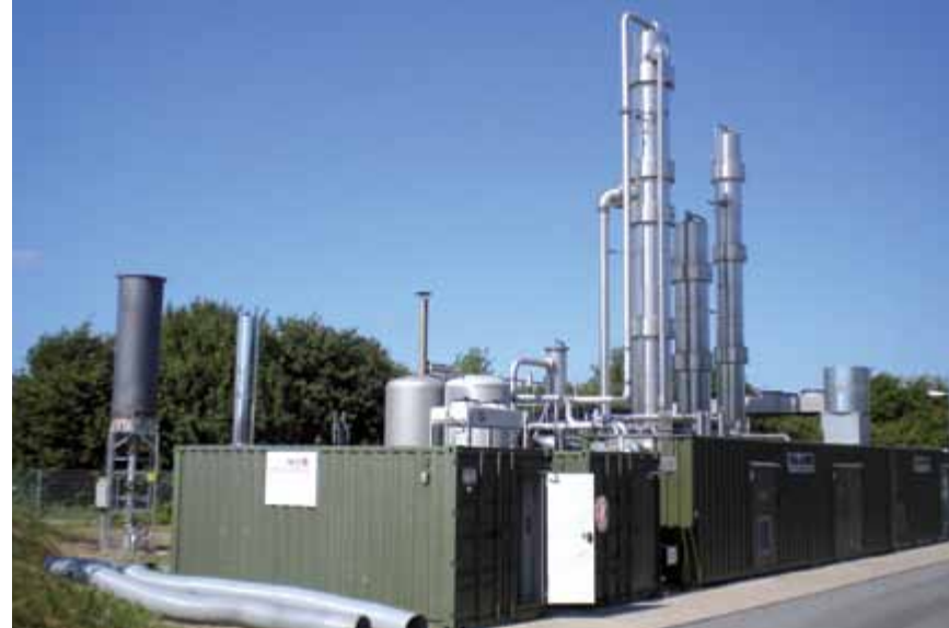
Abb. 9: Physikalische Absorption mit organischen Lösungsmitteln (Genosorb®-Wäsche) [13]
