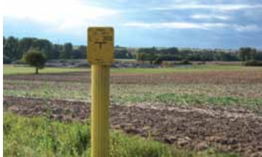
Abb. 16: Erdgasnetz, Hinweisschild auf eine unterirdische Leitung [13]
