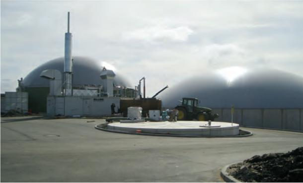
Abb. 49: Güllevorgrube, Fermenter und Nachgärbehälter
