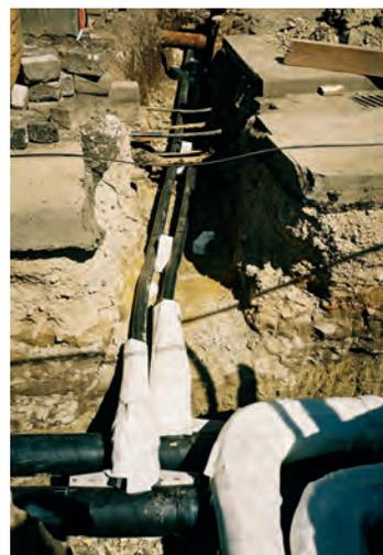
Abb. 17: Verlegung des Nahwärmenetzes in Jühnde
