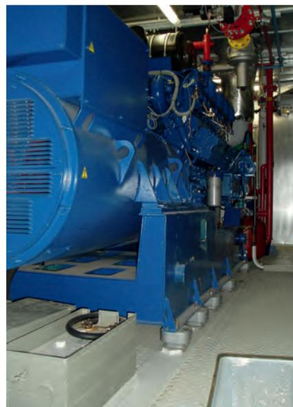
Abb. 52: Motor-Generator-Kombination des Blockheizkraftwerkes (BHKW)
