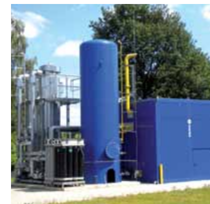
Abb. 12: Druckwechseladsorption [13]
