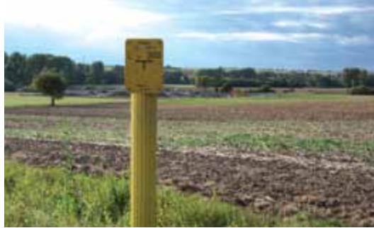
Abb. 16: Erdgasnetz, Hinweisschild auf eine unterirdische Leitung [13]
